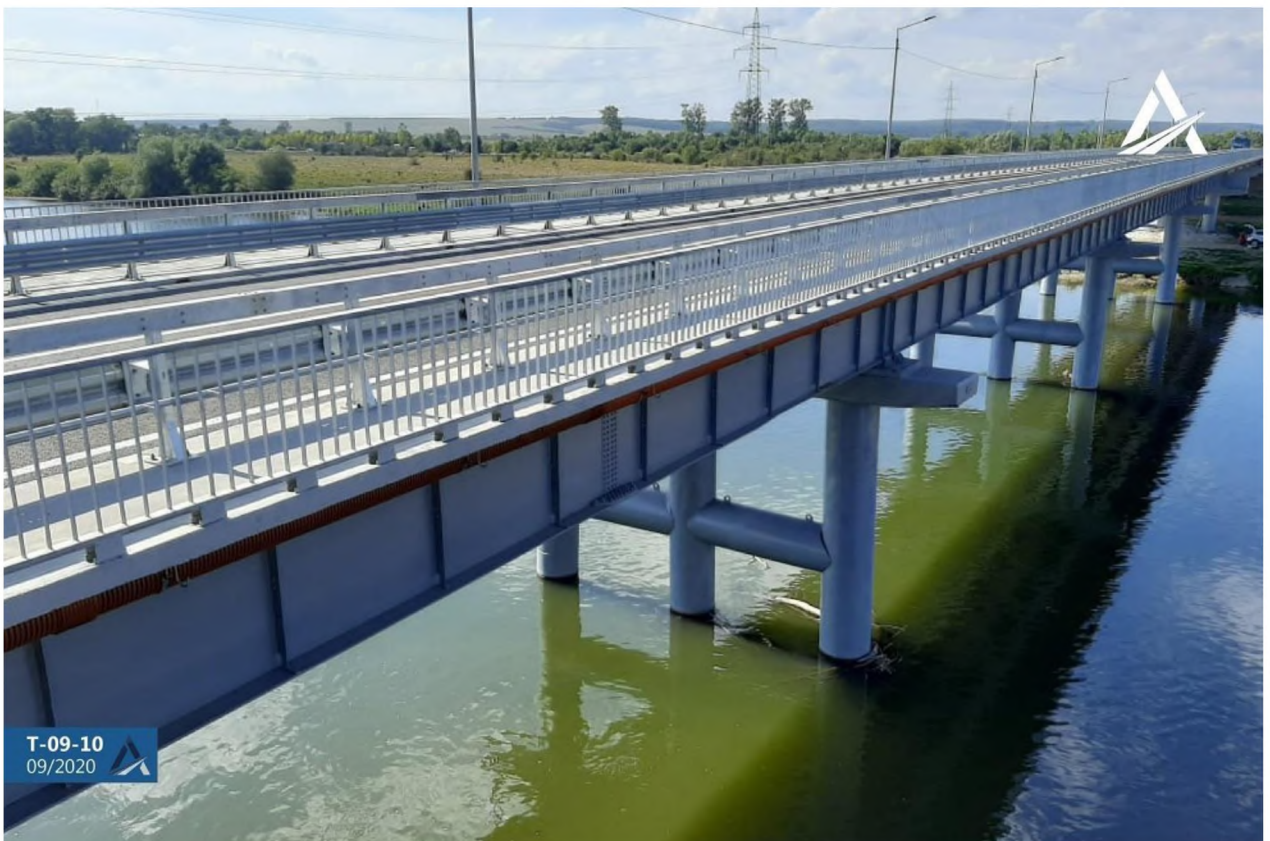
Рис. 2.6 Завершення будівництва мосту через Дністер
