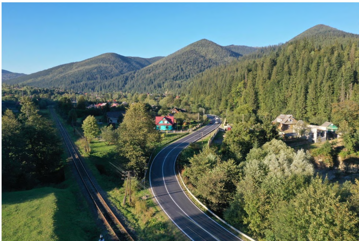
Рис. 2.9 Будівництво дорожнього шляху Татарів – Кам’янець-Подільський
