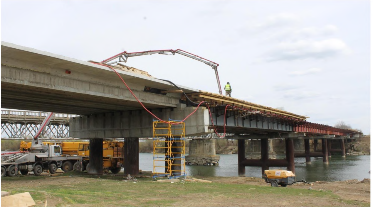
Рис. 2.5 Спорудження мосту через Дністер, км 9+442
