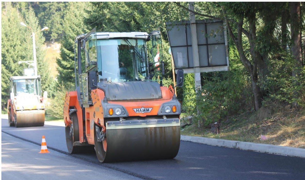
Рис. 2.2 Ремонт дороги Ворохта - Верховина Р-24
