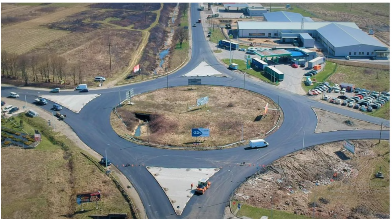
Рис. 2.8 Будівництво кільцевої розв'язки Хуст – Вільхівка
