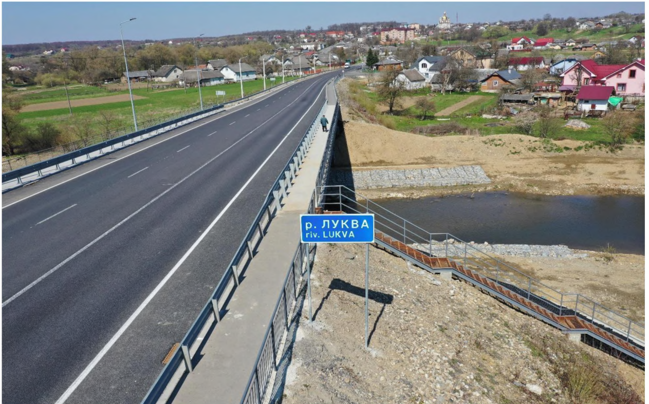
Рис. 2.7 Будівництво моста у Боднарові
