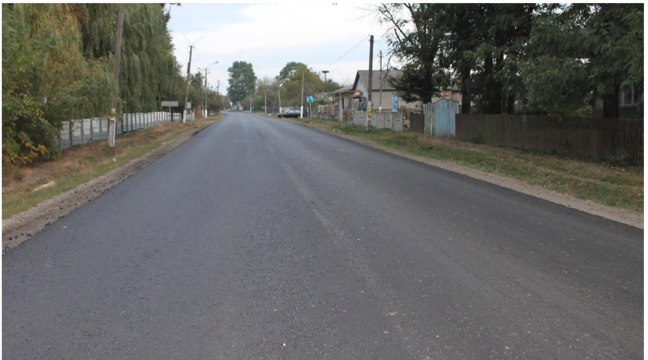
Рис. 2.4 Ділянка дороги після ремонту Р-20
